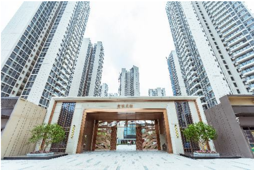
珠实集团旗下广州“攻城拔寨”项目番禺汽车小镇2022年6月共交付2251套住宅，刷新广州市单项目单月交付纪录
